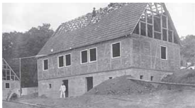
Siedlungshaus in Neuwirtshaus im Bau
